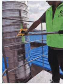
DA002 废气排放口
