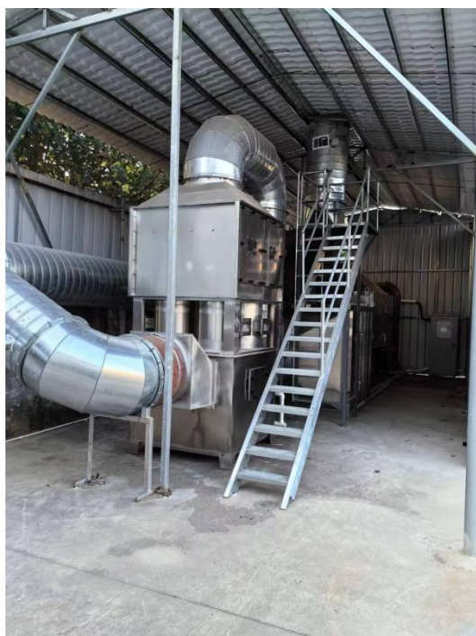
处理措施（“水喷淋+干式过滤+活性炭吸附脱附+催化燃烧”装置）
