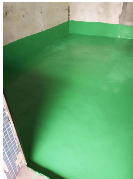
危险废物仓内部防渗图片
