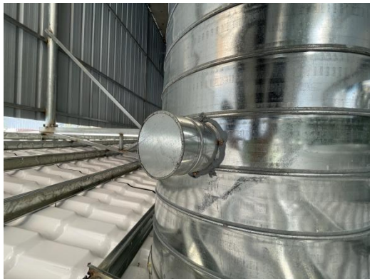
处理后采样口
