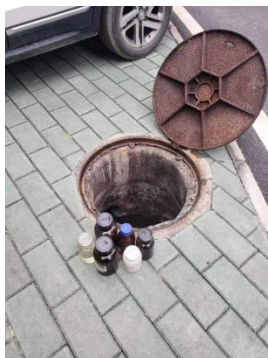
生活污水排放口
